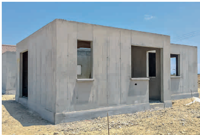
Altos del Mirador Proyecto de viviendas en Coquimbo / IV Región, Chile 200 casas de 2 pisos Planta baja de 58 m 2 de superficie construida en hormigón
