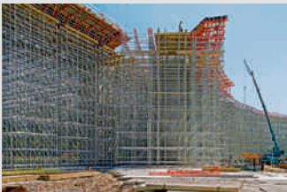
Cimbras y torres de carga
