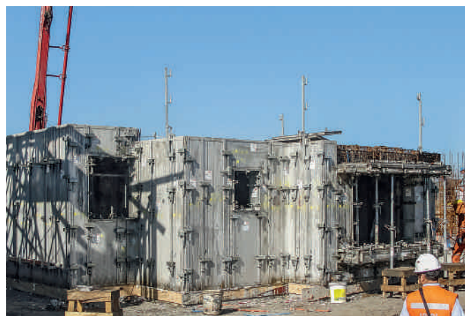
San Andrés del Valle Proyecto de casas en Concepción, Chile 455 casas de 2 pisos Planta baja de 78 m 2 de superficie construida en hormigón
