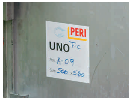
Cada panel lleva un número de posición y puede ubicarse rápida y correctamente con ayuda del correspondiente plano de ubicación.
