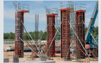
Encofrados para pilares y columnas circulares
