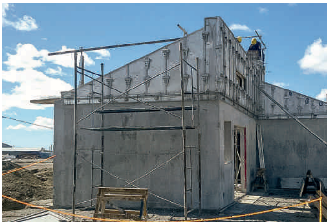
La coronación de muros inclinados también se resuelve con facilidad con UNO.
