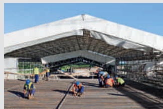
Andamios de protección
