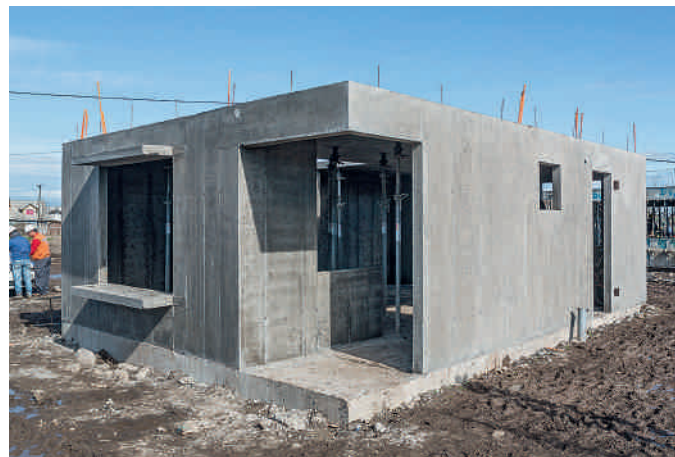
Casas Rehue Proyecto de viviendas en Talca / Región Maule, Chile 350 casas de 2 pisos Planta baja de 68 m 2 de superficie construida en hormigón
