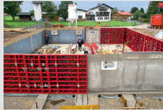
Encofrados para muros
