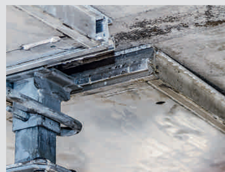
... luego se desmontan las vigas para losa y los paneles. Los puntales con los cabezales de caída permanecen como reapuntalamiento.
