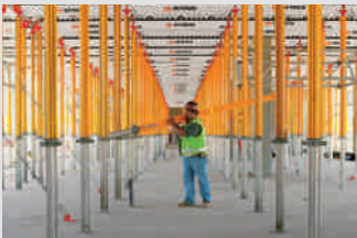
Encofrados para losas
