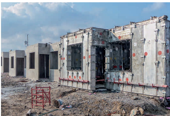
Proyecto de viviendas en Tampico, México 1.500 casas de vivienda de una planta 45 m 2 de superficie por casa, superficies quedan a la vista
