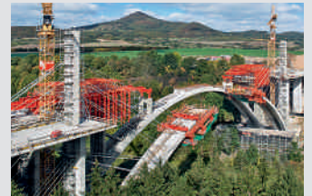
Encofrados para puentes
