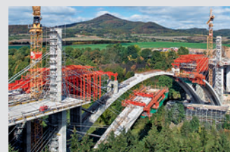
Encofrados para puentes
