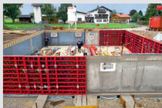
Encofrados para muros
