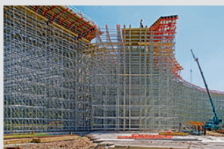
Cimbras y torres de carga
