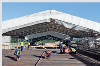
Andamios de protección
