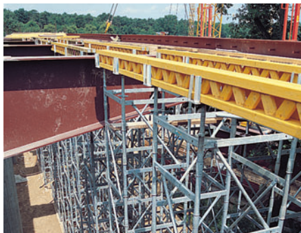
El husillo cabezal ST 100 permite colocar 1 o 2 vigas de modo seguro contra el vuelco.
