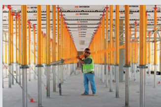
Encofrados para losas
