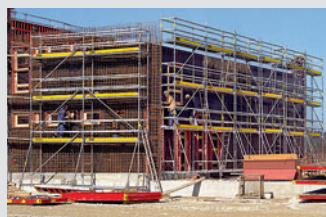
Andamios de trabajo para la construcción
