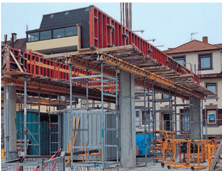
Con la ST 100 pueden hormigonarse previamente incluso vigas de cuelgue pesadas. Y va muy rápido, pues la ST 100 a menudo no requiere diagonales.
